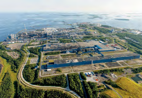
De fabriek van Outokumpu in Tornio produceert 1 miljoen ton roestvrij staal per jaar. | Outokummun tehdas Torniossa tuottaa vuosittain miljoona tonnia ruostumatonta terästä.
